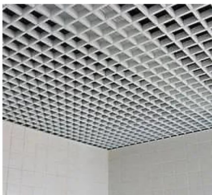
Imagem 2- Forro metálico tipo colmeia
